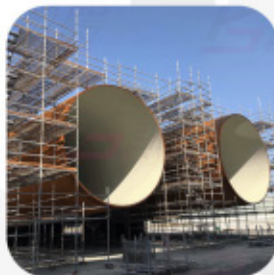
風力發電機座鷹架搭設 防銹塗裝
