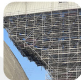
懸空式桁架 鋼構更換
